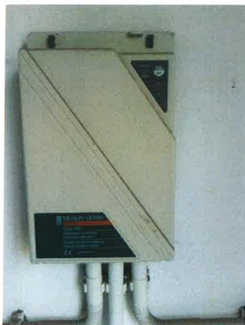
1.2. Trójfazowy Wskaźnik Przepływu Prądów Zakłócenionych (FPI) faza-ziemia i faza-faza, do sygnalizacji lokalnej MERLIN GERIN Flair 279
